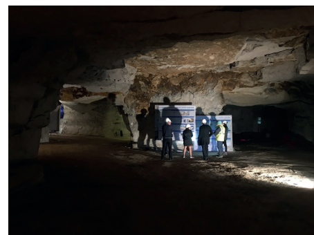
Surveillance d'un pilier en cavité minée
